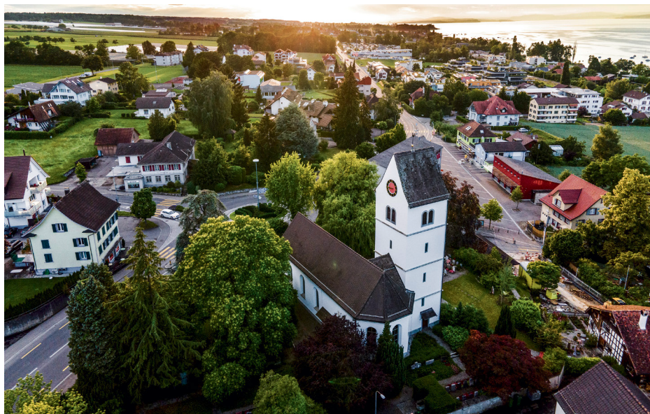
Die Kirchgemeinden Kesswil-Dozwil und Uttwil – die Kirchen im Dorf. Foto: Christian Wieland
